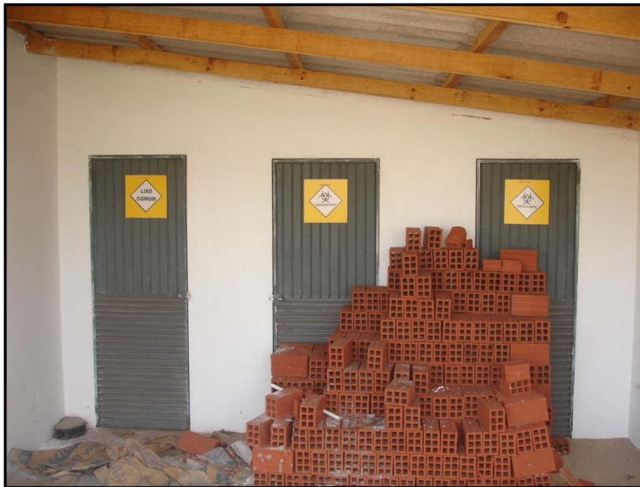
Figura 22: Local de acondicionamento de resíduos em construção
