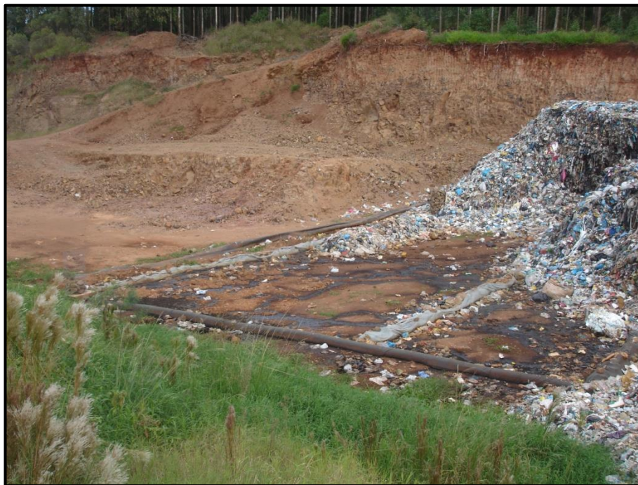
Figura 28: Sistema de drenagem de líquidos percolados
